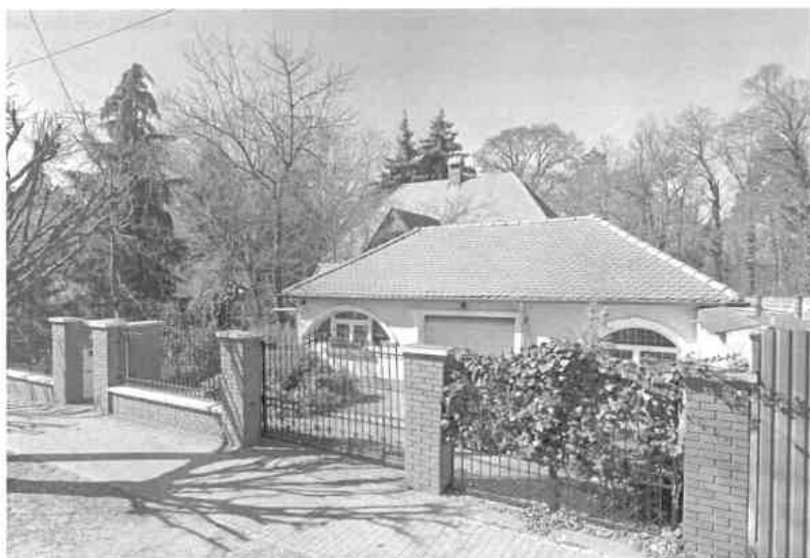
Fasor utca 4. szám alatti ingatlanon elhelyezkedő épület:
