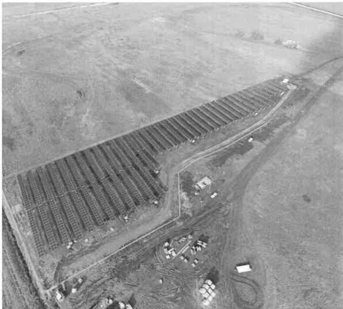
16. ábra Az elkészült napelemes kiserőmű megjelenítése
