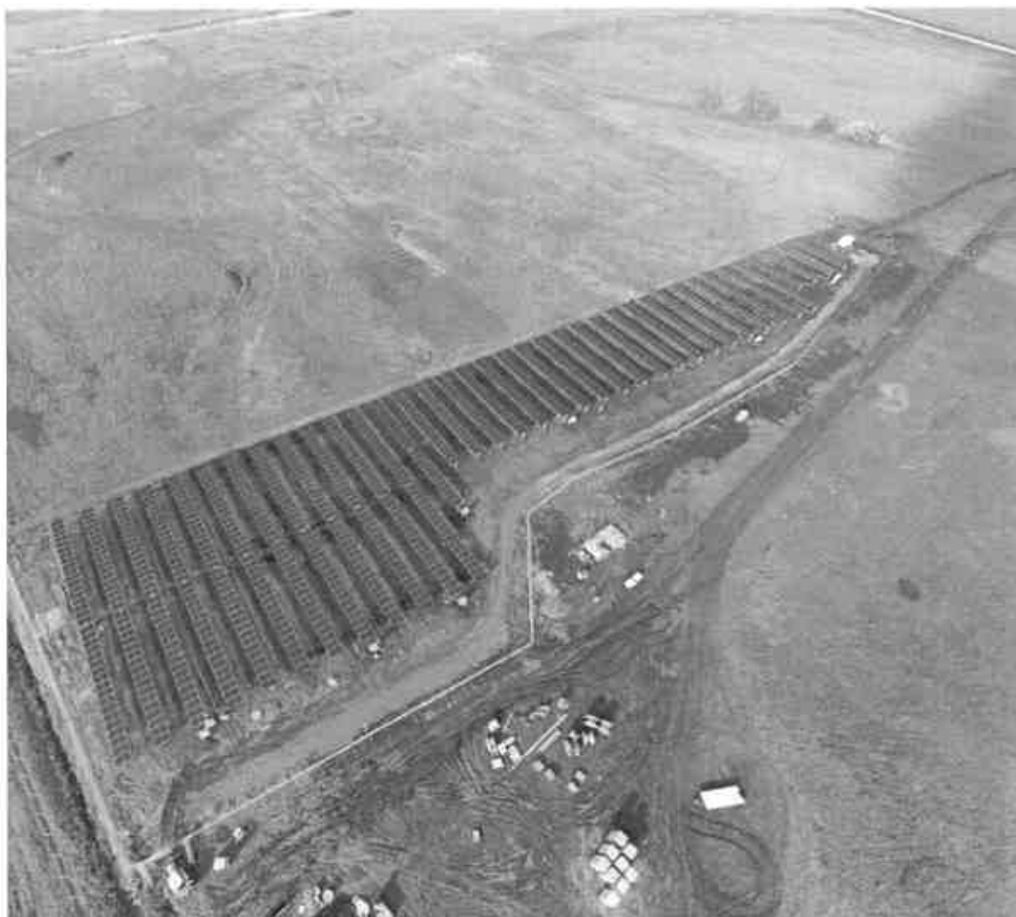
16. ábra Az elkészült napelemes kiserőmű megjelenítése
