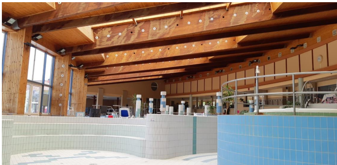
76. ábra: Az élményfürdő medencetere és nedvesedő tetőszerkezete
