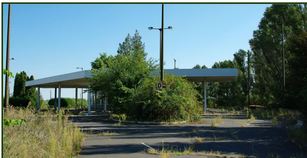
Üzemem kívüli Csorvási úti üzemanyag kút
