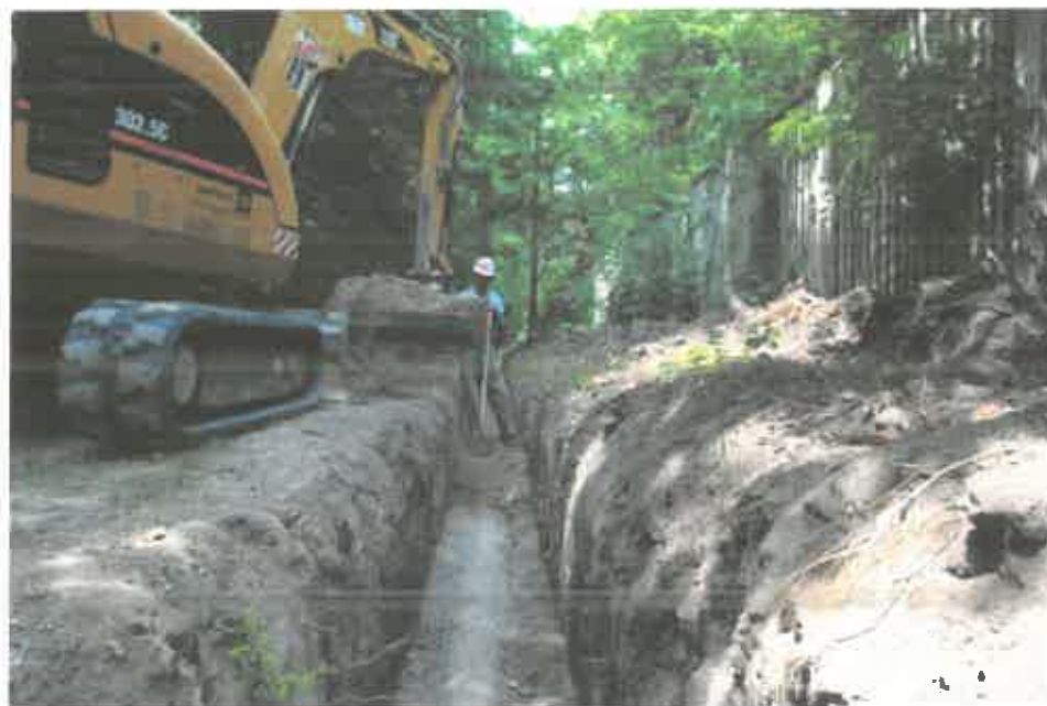
85. ábra: A visszasajtoló vezeték fektetése
