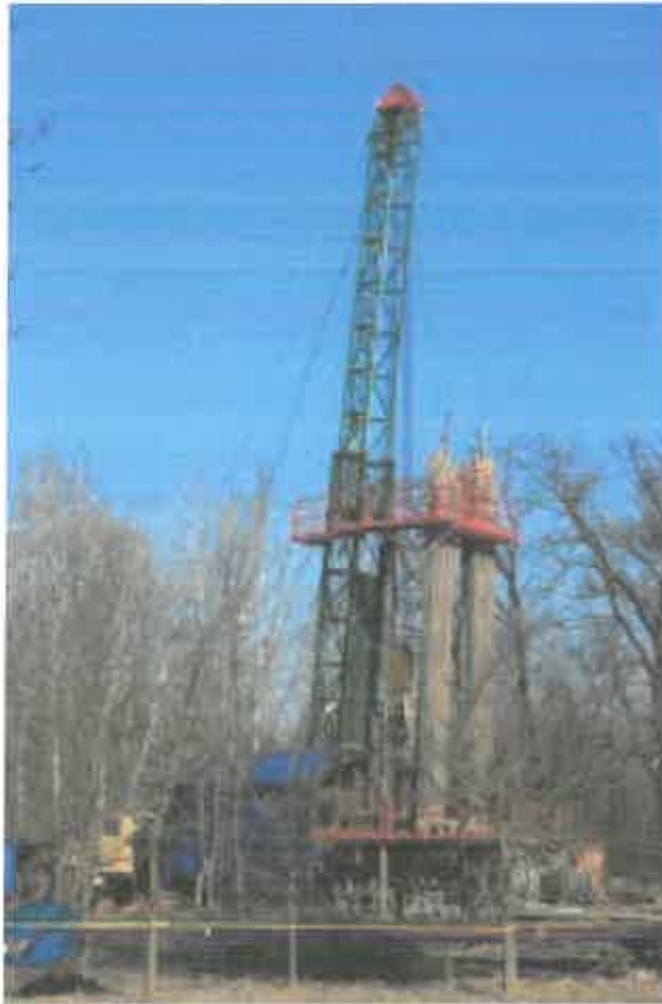
86. ábra: A V-1 jelű visszasajtoló kút fúrása Orosháza-Gyopárosfürdőn
