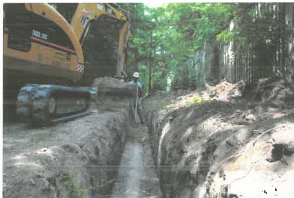
85. ábra: A visszasajtoló vezeték fektetése
