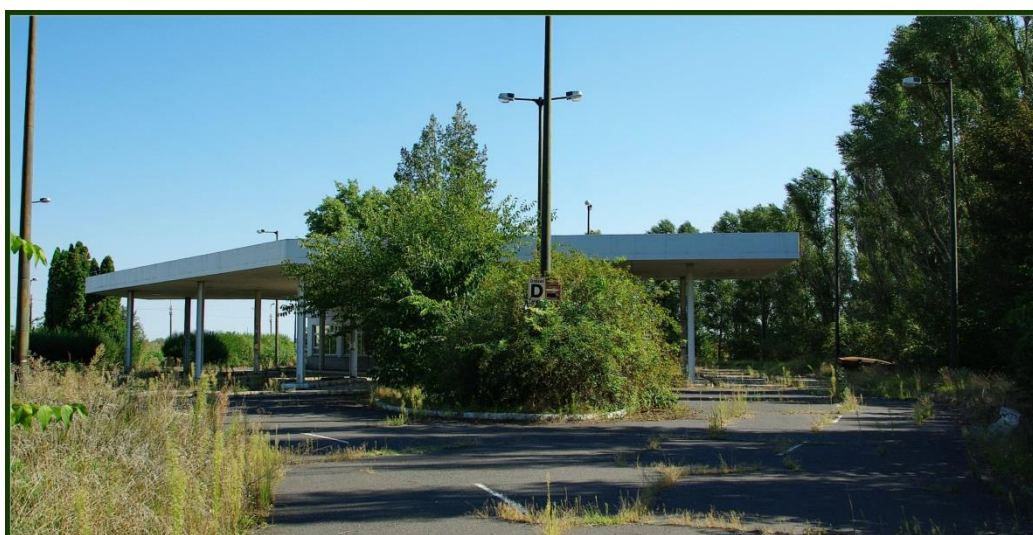
Üzemem kívüli Csorvási úti üzemanyag kút
